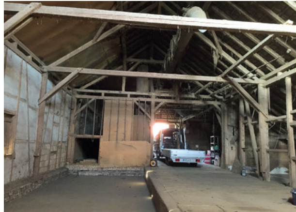
links vorher: Heulager – rechts nachher: Ausbau des Heulagers als Wohnung mit Galerie. Alter Dachstuhl wurde sichtbar erhalten. Gesamtes Gebäck wurde trockenisgestrahlt.
