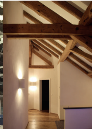
links vorher: Heulager – rechts nachher: Ausbau des Heulagers als Wohnung mit Galerie. Alter Dachstuhl wurde sichtbar erhalten. Gesamtes Gebäck wurde trockenisgestrahlt.
